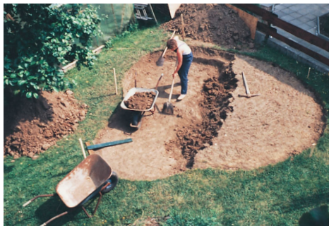
Lo scavo per il laghetto
