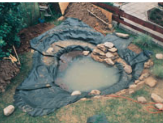
Preparativi per la costruzione di un laghetto con il telo (ved. pag. 12/13)
